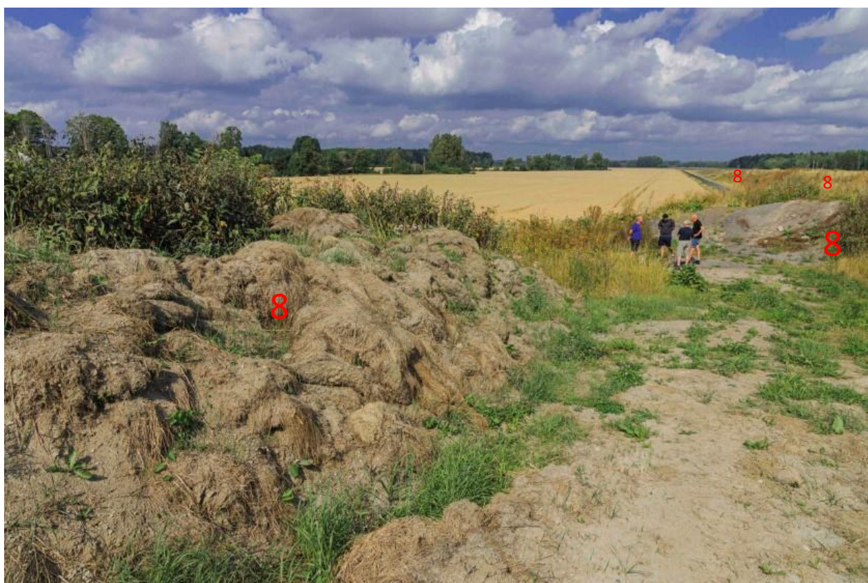
Bild 14. Nytt mycket näringsrikt material läggs fortfarande på bullervallarna vilket kommer att fortsätta underlätta etableringen kvävegynnade växter (åtgärd 8).
