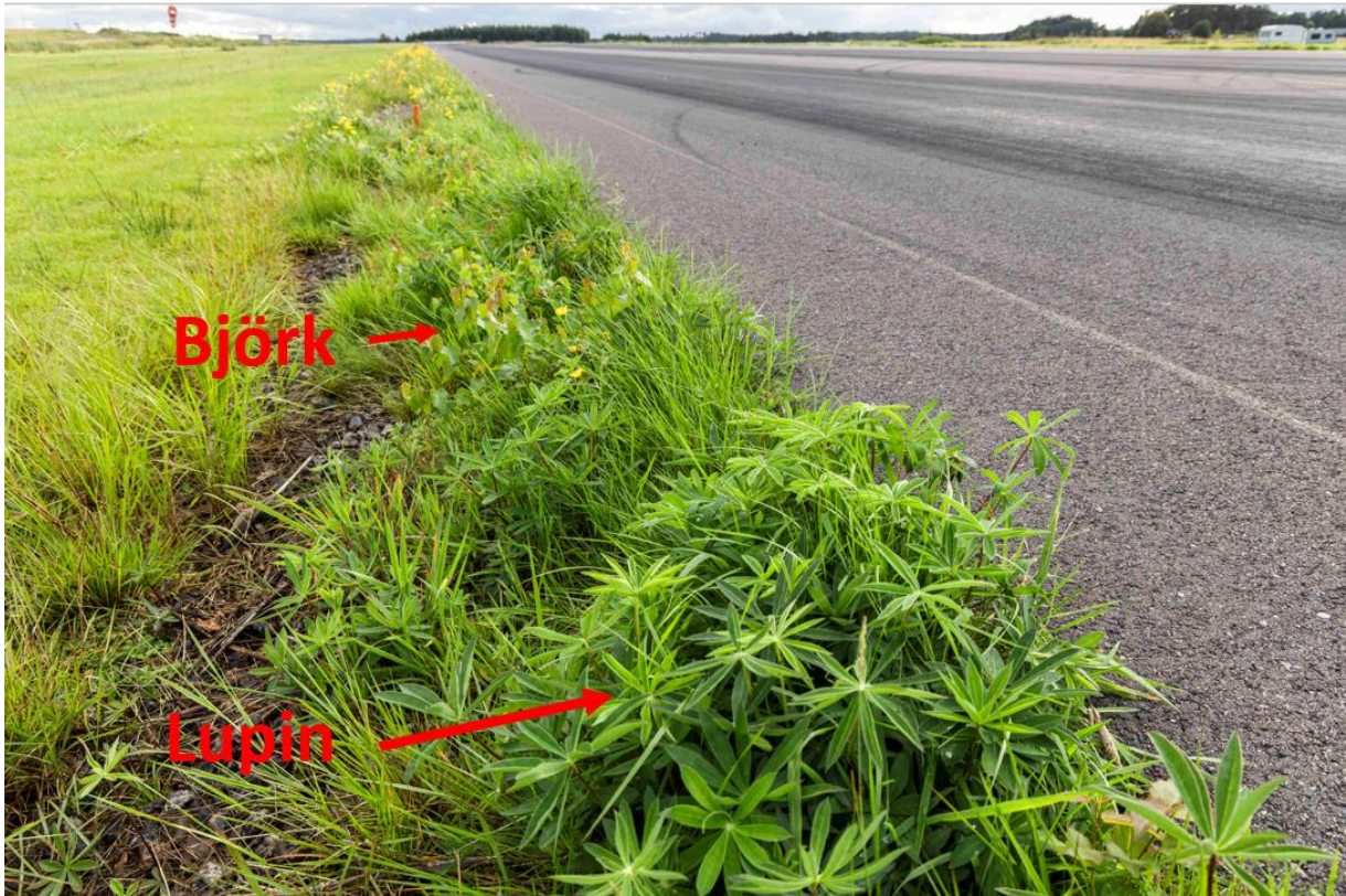
Bild 3. Växtarter med potential att på sikt förstöra bankanten (åtgärd 2).
