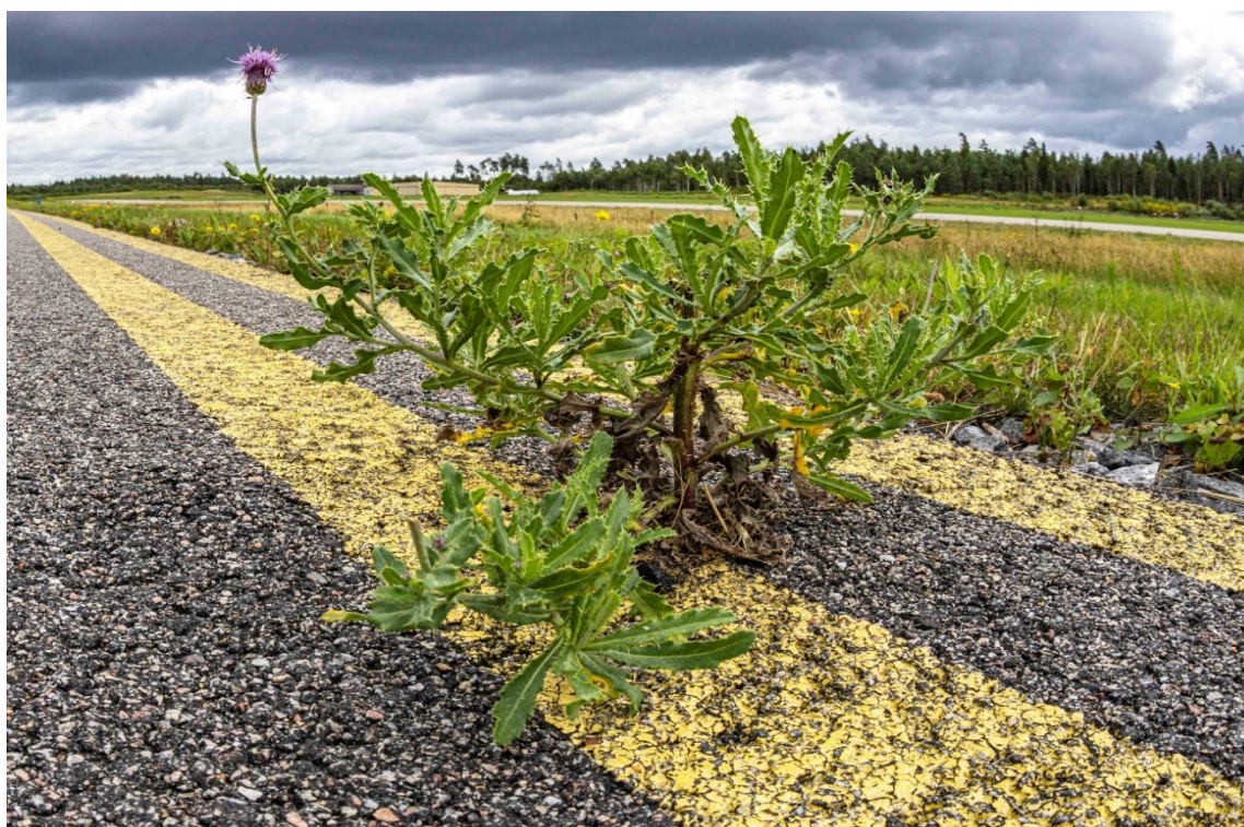
Bild 2. Kraftiga växter har förmåga att växa igenom och bryta sönder asfalt (bilden är inte från Vårgårda) se åtgärd 2.
